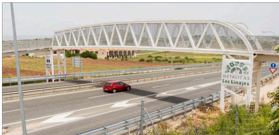
Vista general de la pasarela entre Soria y Las Casas. MARIO TEJEDOR
